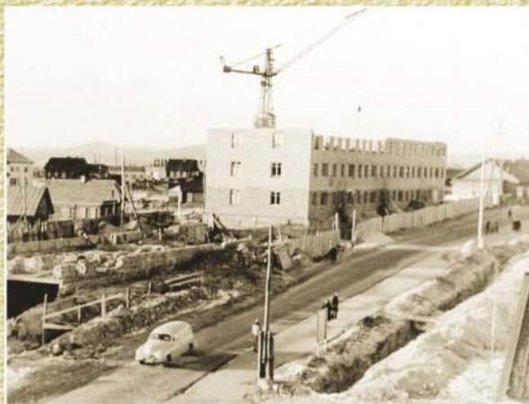
За строящимся зданием скоро поселится суд
